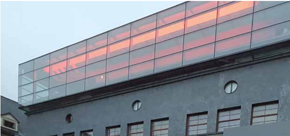
Auch von der Straßenseite aus, zieht der beleuchtete Textil-Luftauslass von FabricAir die Blicke auf sich.
